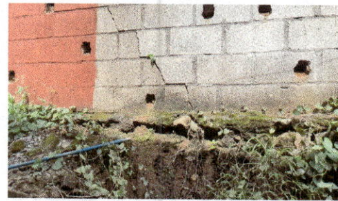
FOTO 6: Reparación de muro de contención
