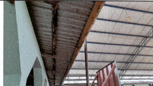
FOTO 4: Sustitución de canal de metal En modulo de aulas
