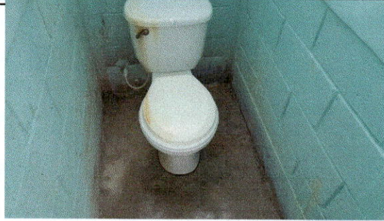
FOTO 1: Sustitución de piso de cemento líquido por piso ceramico
