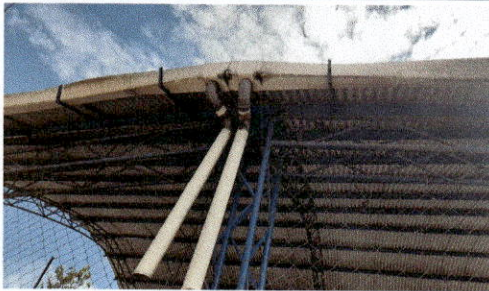
FOTO 5: Sustitución de canal de metal en Modulo de Patio
